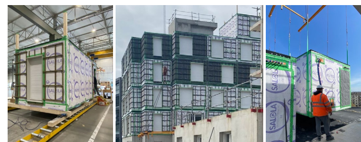
Constellation - résidence étudiant - 480 Logements - Rennes School of Business Construction modulaire bois / mixte structure béton (circulations/noyau + socle) De l'usine de Mayer-Buildtech à la mise en place sur site.... - ACB Architectes
